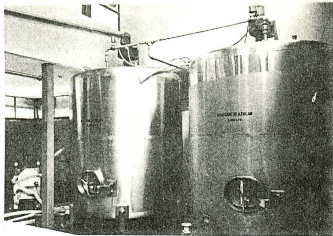
Gigantescos tanques en la sala de jarabes.
