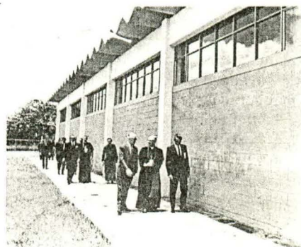
Vista parcial del edificio de la nueva planta de concentrados, que fue visitada por los asistentes.
